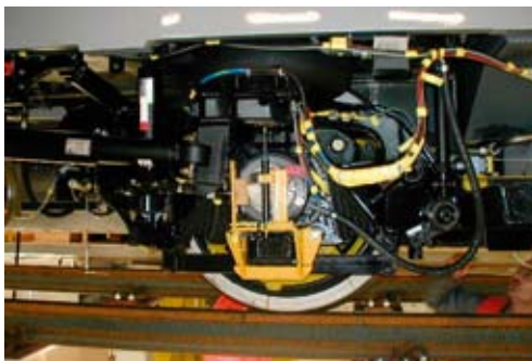
An vier Radsätzen (im Bild ein Einzelachsfahrwerk) wurden die Rad-Schiene-Kräfte mit Messradsätzen gemessen. Weiterhin sind Wegsensoren zur Messung der Federwege und der radialen Einstellung der Radsätze erkennbar.
