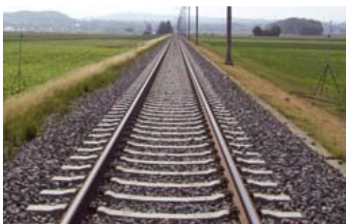
Ansicht der Lärmessstelle mit Mikrofonen links und rechts des Gleises
