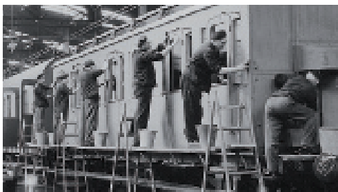
Travail de maintenance d'un wagon il y a 100
